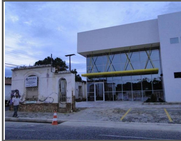
Imagem 02: Residência eclética demolida para dar espaço a centro médico. Apenas parte da fachada foi mantida. Fonte: MOREIRA, Amanda. 2011.
